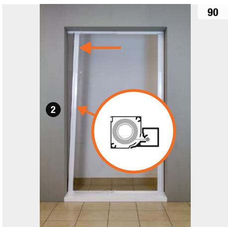
Installazione con biadesivo. Sgrassare e asciugare la superficie di fissaggio prima di incollare il biadesivo: la completa adesione si ottiene dopo almeno 24 ore. In alternativa procedere con l'installazione con viti.
