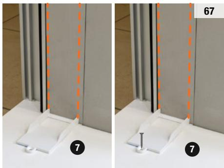
Installazione con biadesivo. Sgrassare e asciugare la superficie di fissaggio prima di incollare il biadesivo: la completa adesione si ottiene dopo almeno 24 ore. In alternativa procedere con l'installazione con viti.
