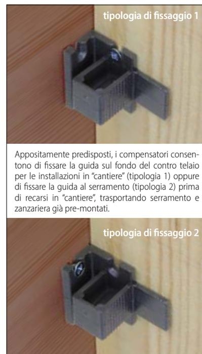
Appositamente predisposti, i compensatori consentono di fissare la guida sul fondo del contro telaio per le installazioni in "cantiere" (tipologia 1) oppure di fissare la guida al serramento (tipologia 2) prima di recarsi in "cantiere", trasportando serramento e zanzariera già pre-montati.
