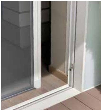
Il blocco meccanico della maniglia in qualsiasi posizione permette di **non utilizzare profili di chiusura**. Quindi la zanzariera **occupava solamente due lati del nostro vano** e ci permette di installarla senza forare le pareti (tramite speciale biadesivo) o al massimo con 2/3 viti.
