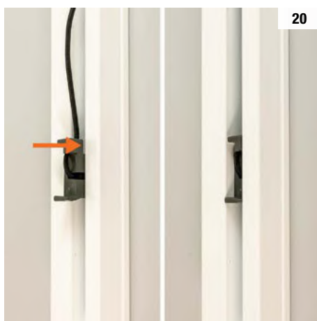
Fare attenzione a non pizzicare il cavo di ricarica interno nero e l'antenna del motore
