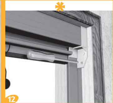
Inserire i PARASPIGOLI alle estremità della barra maniglia
